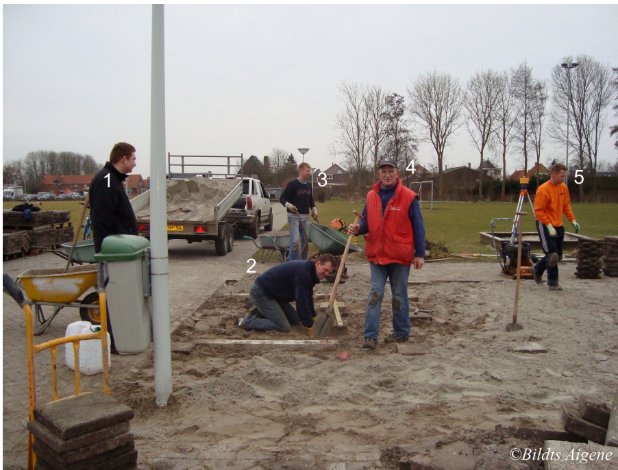
Grondwerkzaamheden t.b.v. “bushokje” bij de Fijfskaar
